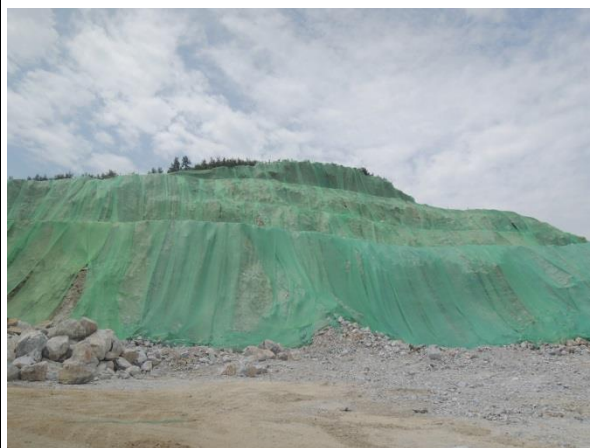
露天采场临时覆盖
