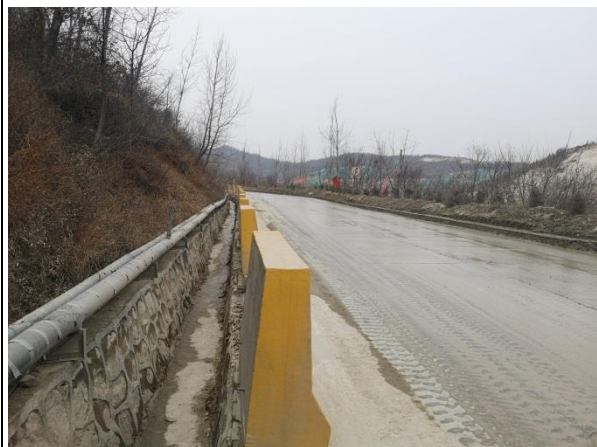
矿山道路区排水沟
